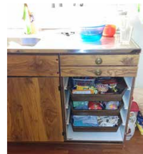
Tommys Sigdal-kjøkken fra 1979 er et levende bevis på at hengsler, skuffeskiner og skuffer i plast ikke var en veldig god idé.
