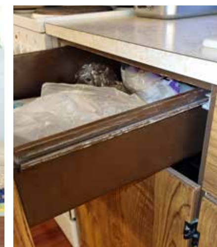
Tommys Sigdal-kjøkken fra 1979 er et levende bevis på at hengsler, skuffeskiner og skuffer i plast ikke var en veldig god idé.
