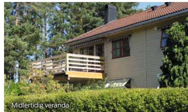
Verandaene med glassrekkverk ferdigstilles.
